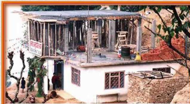
ネパールのジャスカン村にコミュニティ・ビルディング建設
