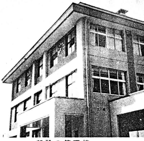
新設の管理棟
