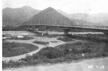
橋桁が美しい坂城大橋
