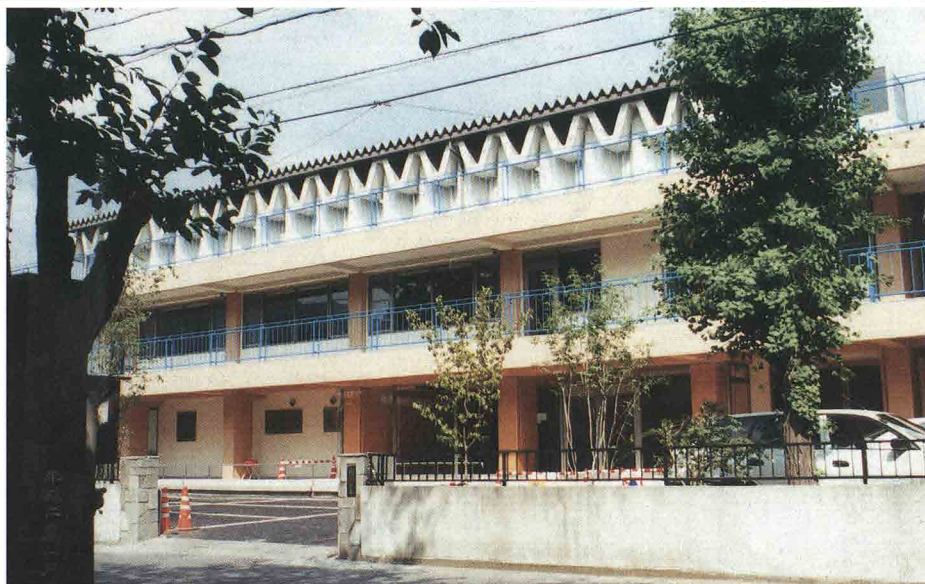
36年ぶりのお色直し……完成した同窓会館外景
