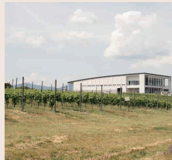
建設中の梔子ワイナリー
